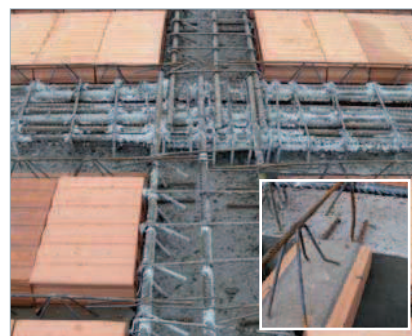
uložení trámečků do železobetonového průvlaku
