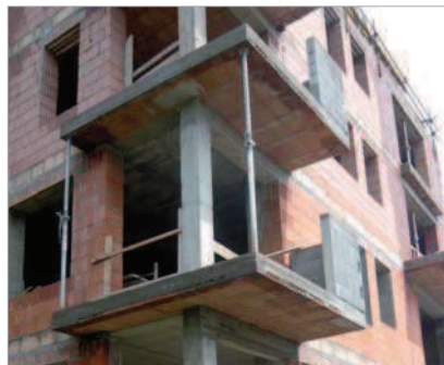
rohový balkón s přidanou výztuží
