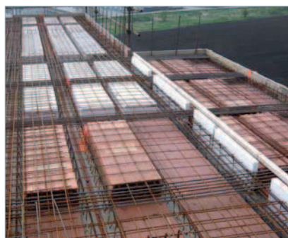
přerušení tepelného mostu mezi balkónem a stropem
