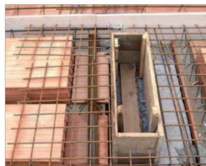
výměna u prostupu stropem pomocí vloženého úhelníku 75/50/6
