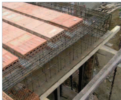
napojení na průvlak u rohového okna bez sloupku
