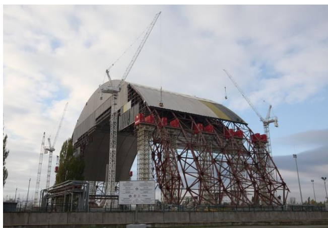
Odhalená nosná konstrukce nového sarkofágu [1]
