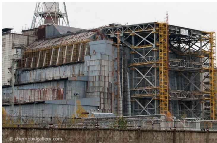
Nová ocelová stabilizační konstrukce [2]
