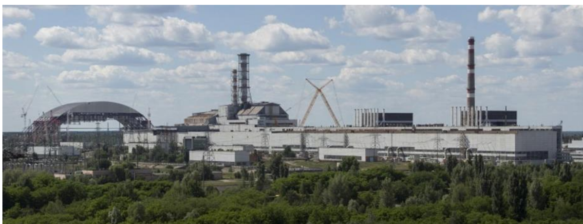
Stavba elektrárny byla započata v roce 1970 zahájením stavby bloku reaktoru č.1. [1]
