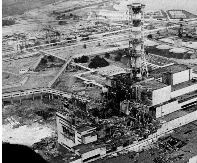
Obr. 2. Pohled na elektrárnu po havárii[7]
