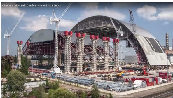
Obr. 9 Výstavba nového krytu [9]
