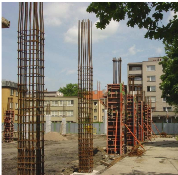
Realizace výztuže, bednění
