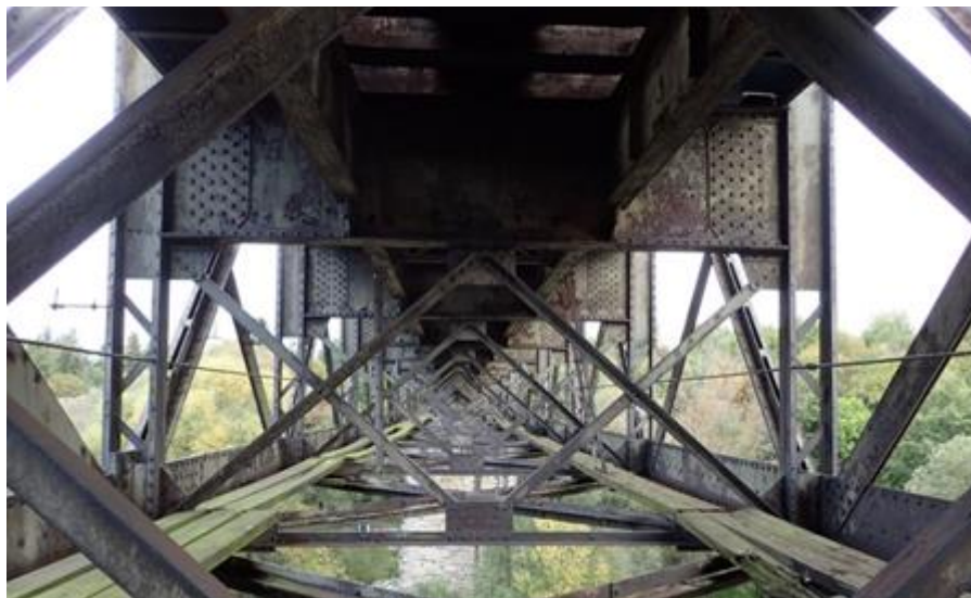
Obr. 40 Pohled do nosné konstrukce středního pole v úrovni dolního pásu
