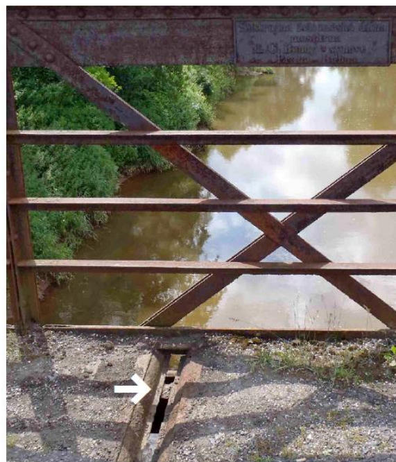
Obr. 53 Korozní oslabení krčných úhelníků v úrovni vozovky a degradovaná vozovka s odhalenými podlažnicemi
