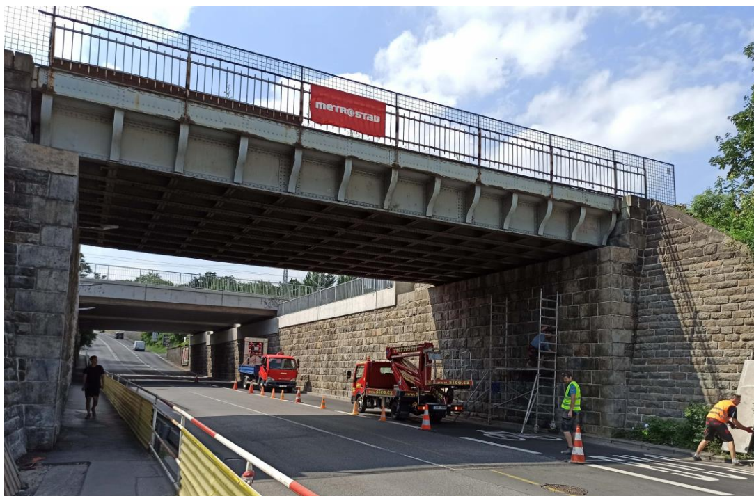
Obr. 46 Pohled na most od severu v roce 2021
