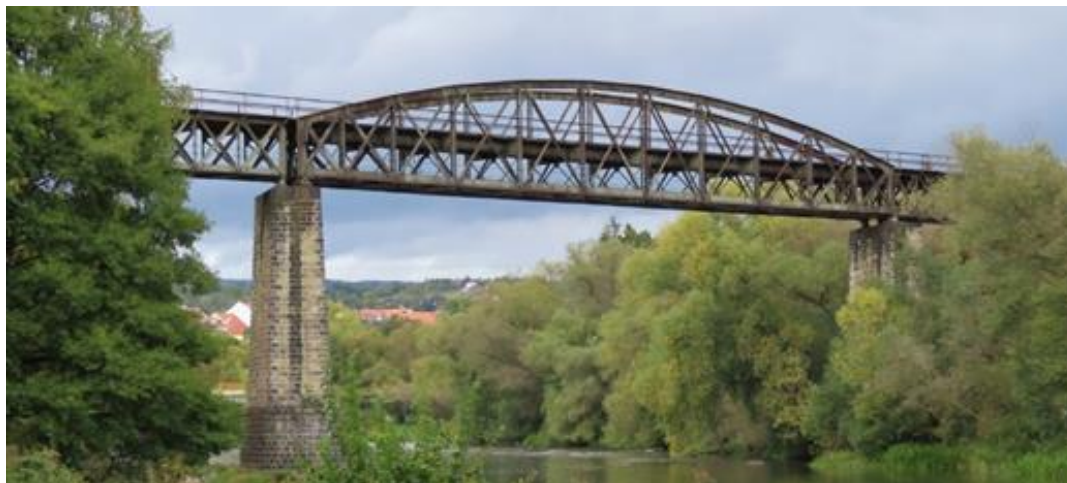
Obr. 39 Most v Kadani – pohled na střední pole (rozhodující konstrukce)
