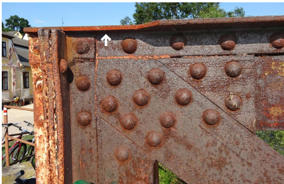
Obr. 52 Odběr vzorku z úhelníku horního pásu
