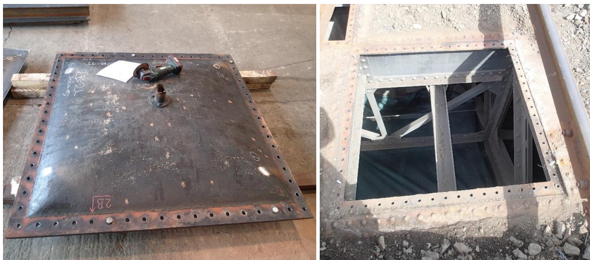
Obr. 41 Odebraný plech puklovky a část mostovky, kde byla osazena
