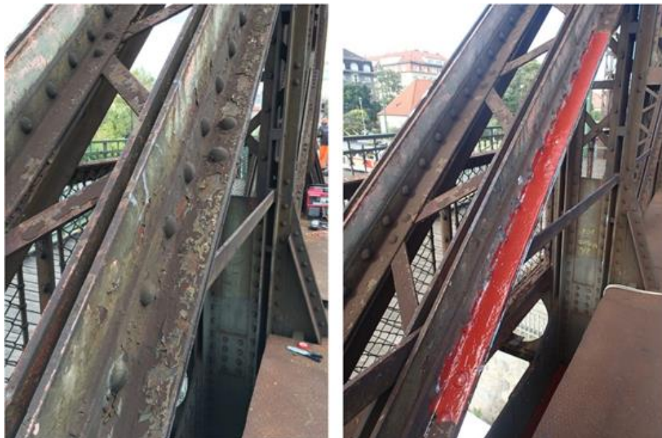
Obr. 37 a) Diagonála mostu před a b) po zesílení lepenou lamelou CFRP
