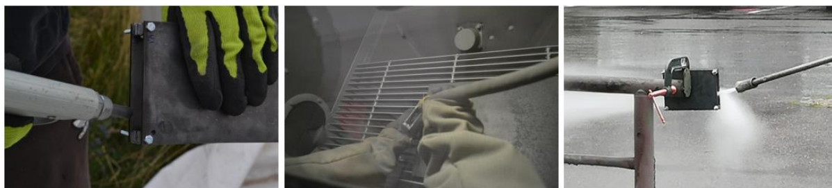
Obr. 36 Druhy mechanického čištění (zleva - tryskání křemičitým pískem, tryskání ocelovou drtí a tryskání tlakovou vodou)
