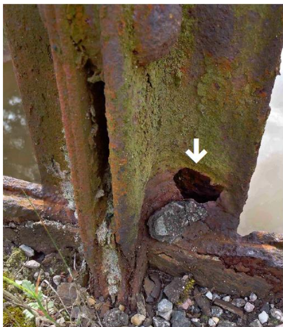
Obr. 53 Korozní oslabení krčných úhelníků v úrovni vozovky a degradovaná vozovka s odhalenými podlažnicemi
