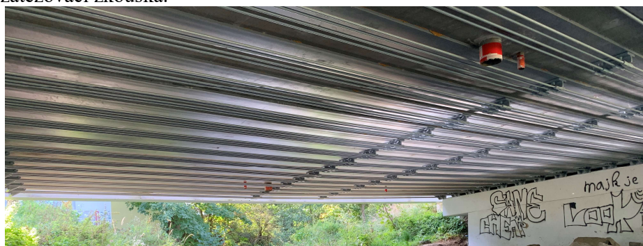
Obr. 8 Osazený systém zesílení pod každým nosníkem v délce 12 m
