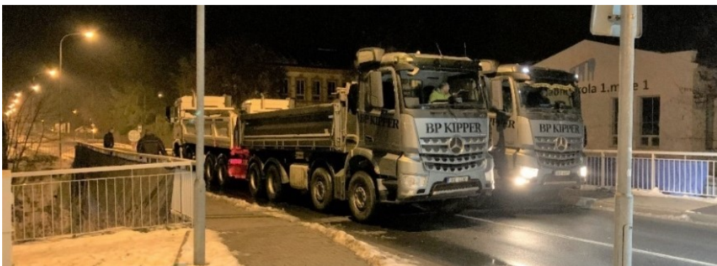
Obr. 11 Statická zatěžovací zkouška se čtveřicí nákladních vozidel o tíze 32 tun
