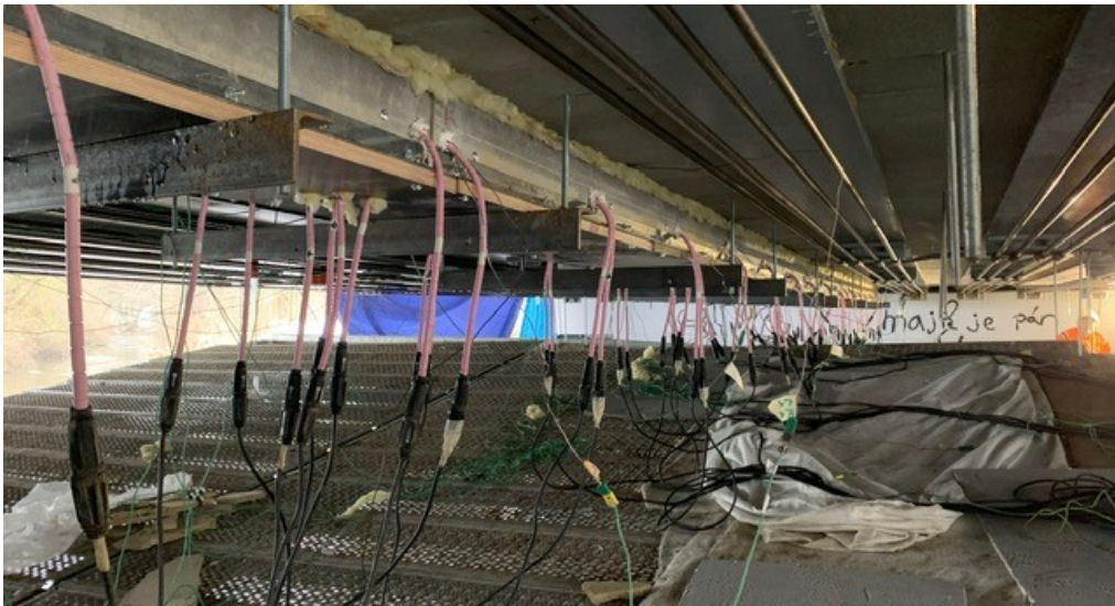
Obr. 10 Aktivace zesílení pomocí ohřevných deček a aktivačních kastlíků s tepelnou izolací
