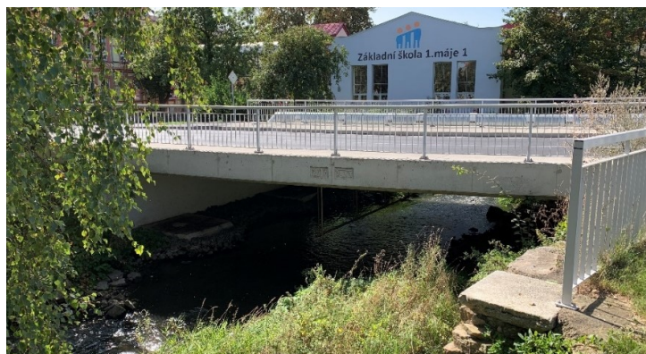
Obr. 7 Most ev. č. M-27
