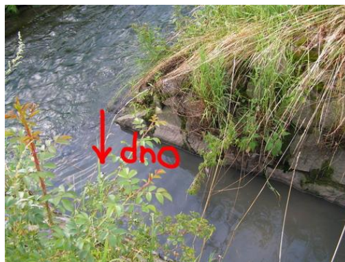
Obr. 10 Ukázka různých druhů výustí – šipka označuje, které místo je bráno za dno výustě
