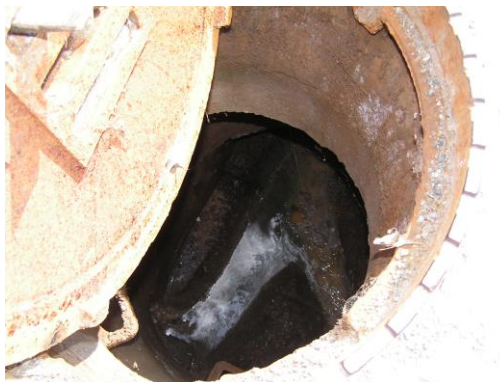
Obr. 8 Spojná komora (2 pøítoky a 1 odtok)
