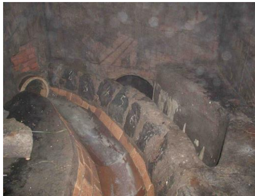
Obr. 5 Přítok do odlehčovací komory
