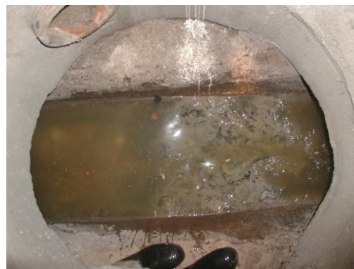
Obr. 9 Kanalizační šachta pøímá
