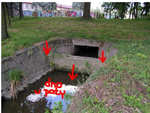
Obr. 10 Ukázka různých druhů výustí – šipka označuje, které místo je bráno za dno výustě
