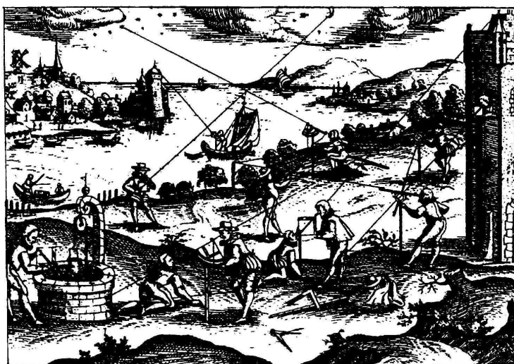
Obr. 3 Určování svislých úhlů v denní praxi geometrů vrcholného středověku a novověku
