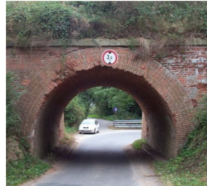
(d) brick: hybrid (2 effective rings)
