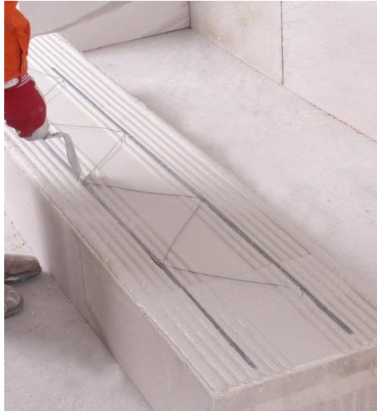
Obr. 13 Výztuž MURFOR® v ložné spáře zdiva brání vzniku trhlin a zvyšuje únosnost prvku v ohybu.
