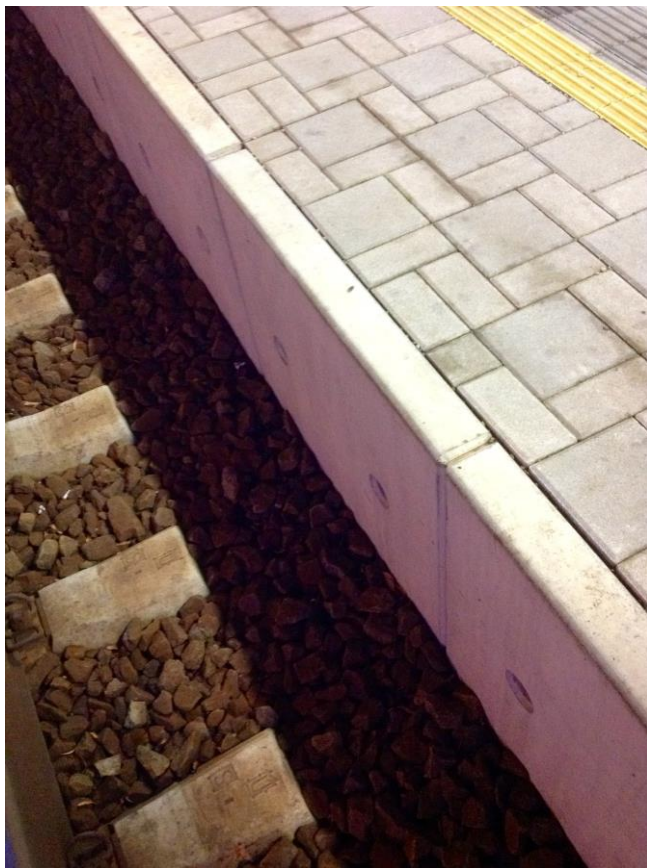
Obr. 5 – Vhodné konstrukční řešení
